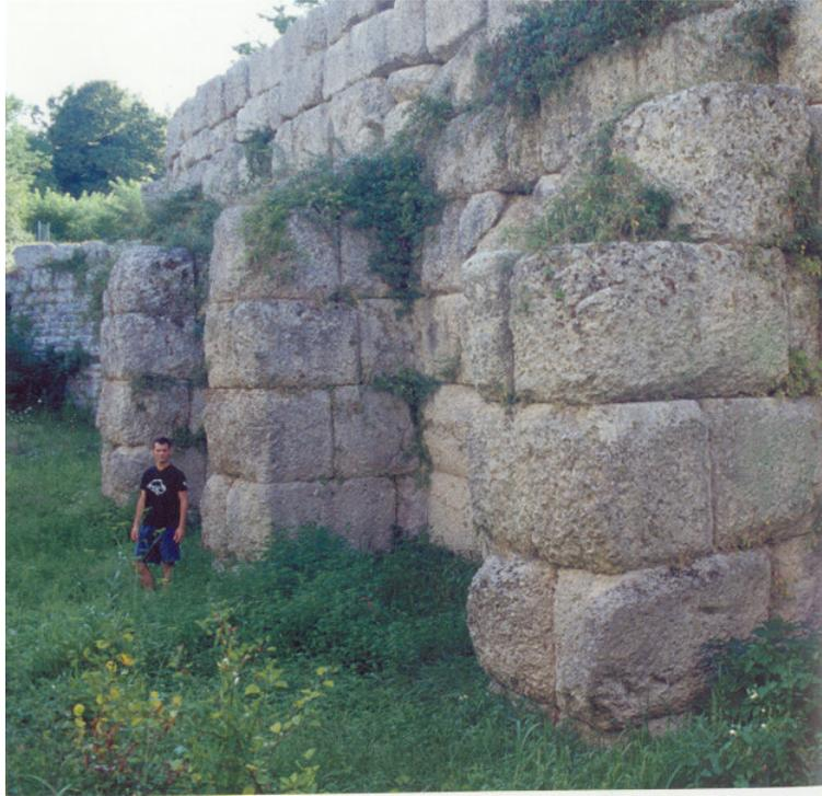
Figura 1.1: Muro de contención romano en la Vía Flaminia, en Cagli (Italia) (foto: M. Durán[7]). Impresionante la dimensión global del muro y de los sillares que lo componen. La pujanza de la economía romana permitió ejecutar obras de estas dimensiones que, en otros tiempos, se habrían evitado con un cambio de trazado.
