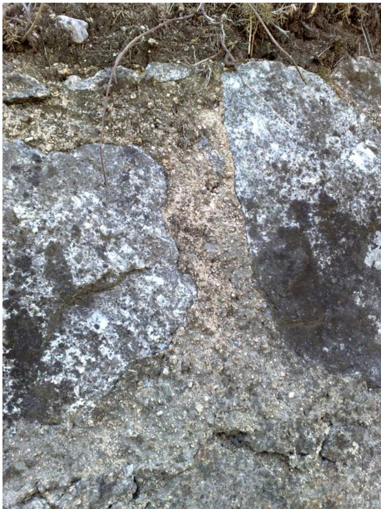
Figura A.3: *Contrafuertes de contención de ferrocarril en La Coruña. Detalle del conglomerante en las juntas (1). Si bien la base parece recientemente revocada con mortero convencional, el material en los contrafuertes parece diferente.*
