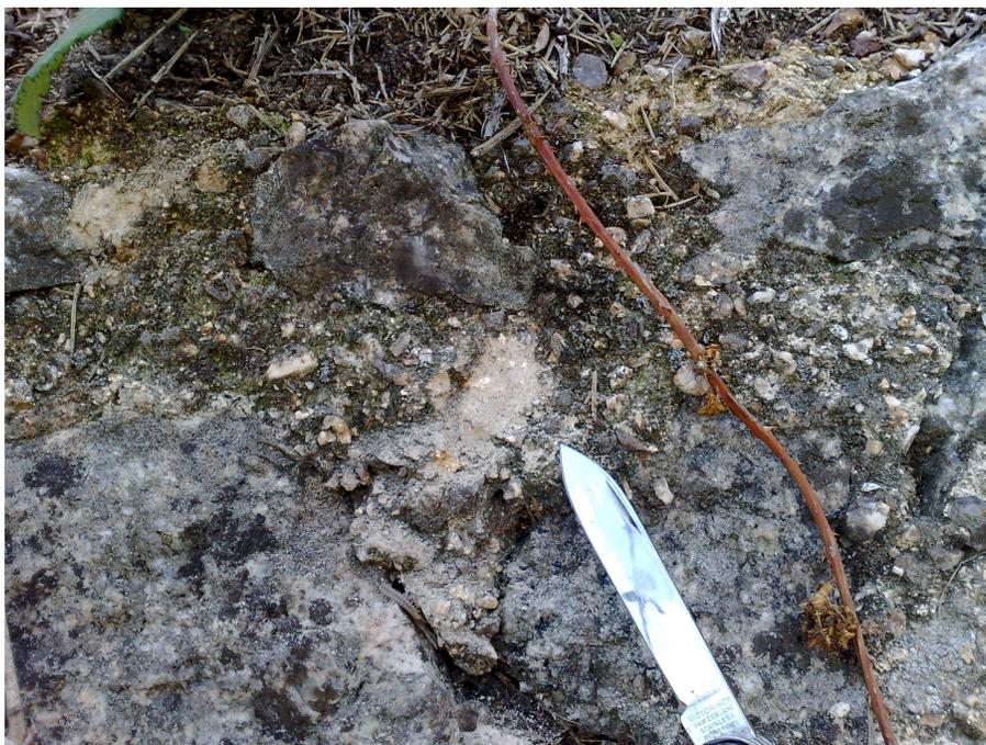
Figura A.4: *Contrafuertes de contención de ferrocarril en La Coruña. Detalle del conglomerante en las juntas (2). Arañando con un cortaplumas, el material se disgrega con cierta facilidad, parece argamasa de cal, lo que, desde mis limitados conocimientos, apuntaría como pronto, al primer tercio del siglo XX, si no más antiguo. Habría que comprobar cuando se ejecutó ese tramo del ferrocarril hacia la terminal de pasajeros.*
