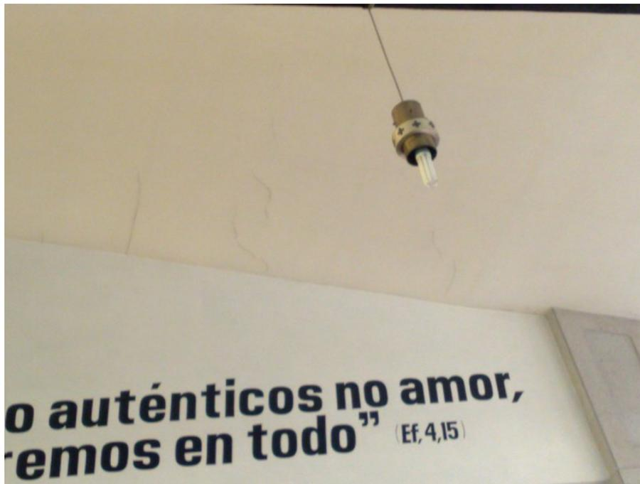
Figura A.21: *Iglesia de Santiago Apóstol, Narón. Detalle de fisuración (2). Grietas de flexión por peso propio*
