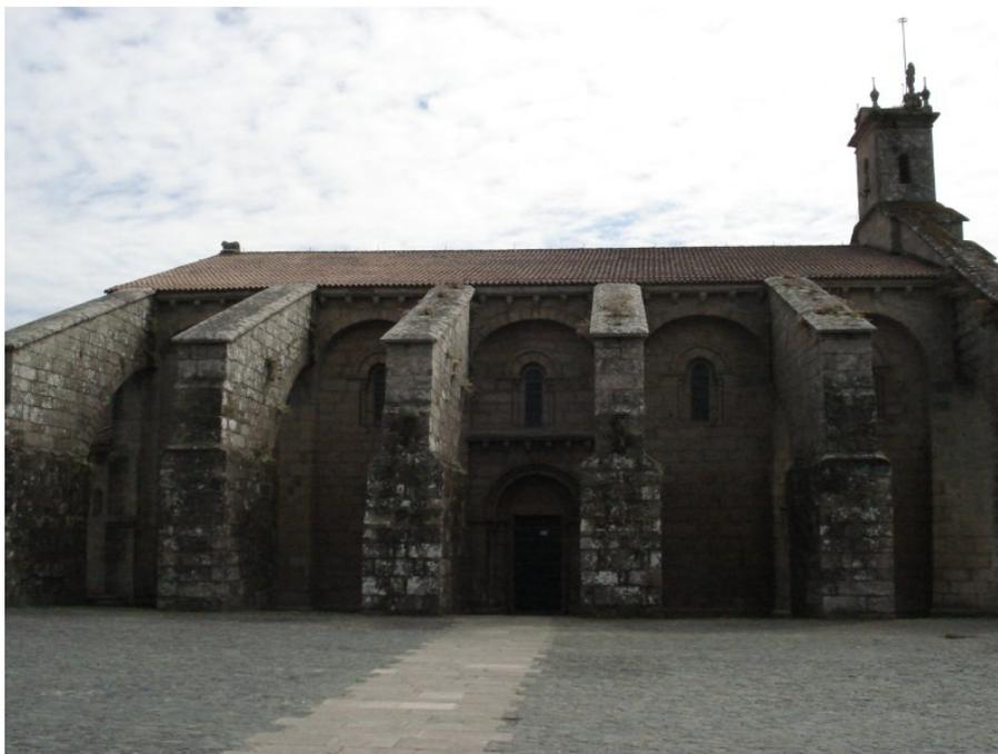
Figura A.10: *Colegiata de Santa María del Sar. Visión lateral. Desde cualquier punto se entienden como descontextualizados, pero necesarios, los contrafuertes laterales (Foto: B. Lombardía)*
