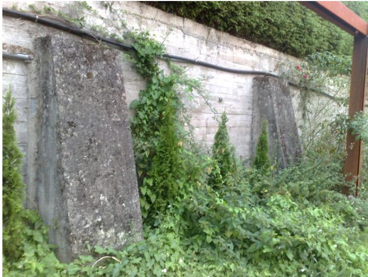
Figura A.5: Muro de contención en el apeadero del ferrocarril en Miño. Por la erosionada superficie de hormigón, debió ser construido en los años 60-70. Los contrafuertes parecen un tanto sobredimensionados, y es posible por tanto, que tengan también un componente estético, de evocación a la antigüedad, desde el punto de vista del diseñador.
