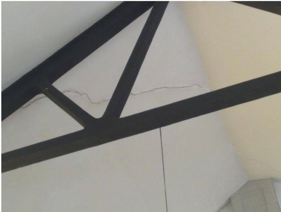
Figura A.20: *Iglesia de Santiago Apóstol, Narón. Detalle de fisuración (1). Grieta que arranca desde el apoyo sobre la celosía de madera, y fisura de punzonamiento alrededor del pilar*
