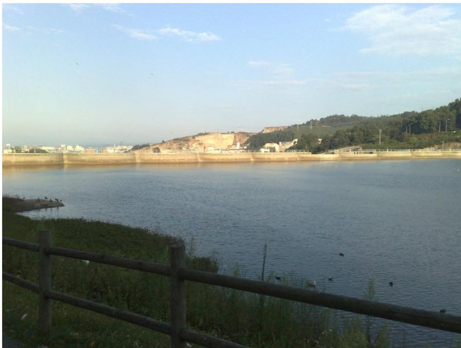
Figura A.7: *Presa de Meicende. Vista general aguas arriba. La cerrada tiene una longitud de 285 metros, y la altura de la presa son 20 metros.*
