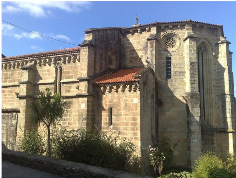
*Figura A.13: Iglesia de Santa María del Azogue, Betanzos. Sistemas de contrafuertes laterales y en el ábside*
