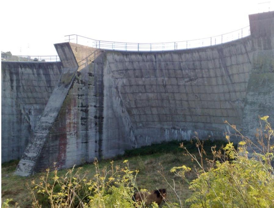
Figura A.9: Presa de Meicende. Vista detalle del intradós. Cada una de las bóvedas tenía 1 metro de espesor, 11 metros de radio, lo que supuso un salto importante para lo que habitualmente se venía haciendo y  $60^\circ$  de desplome. Los contrafuertes tienen un ancho de 2.50 metros
