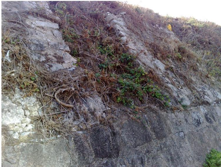
Figura A.1: *Contrafuertes de contención de ferrocarril en La Coruña. Visión general: el careado de la mampostería en los tres planos visibles descarta que estemos ante los restos de un muro de trasdós inclinado completo.*
